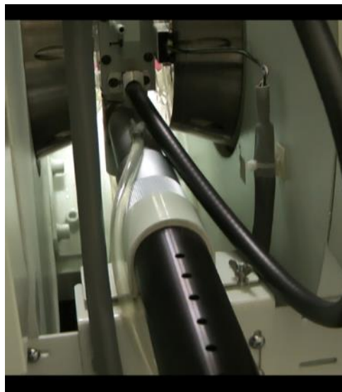
図6 加熱送風管取り付け後の様子
